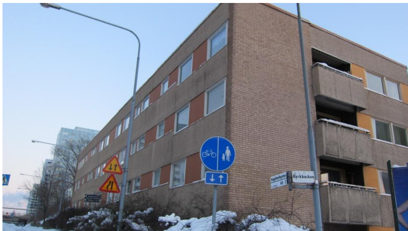
Figur 11, Typiskt lamellhus från miljonprogrammet. Bilden är tagen av författarna.
