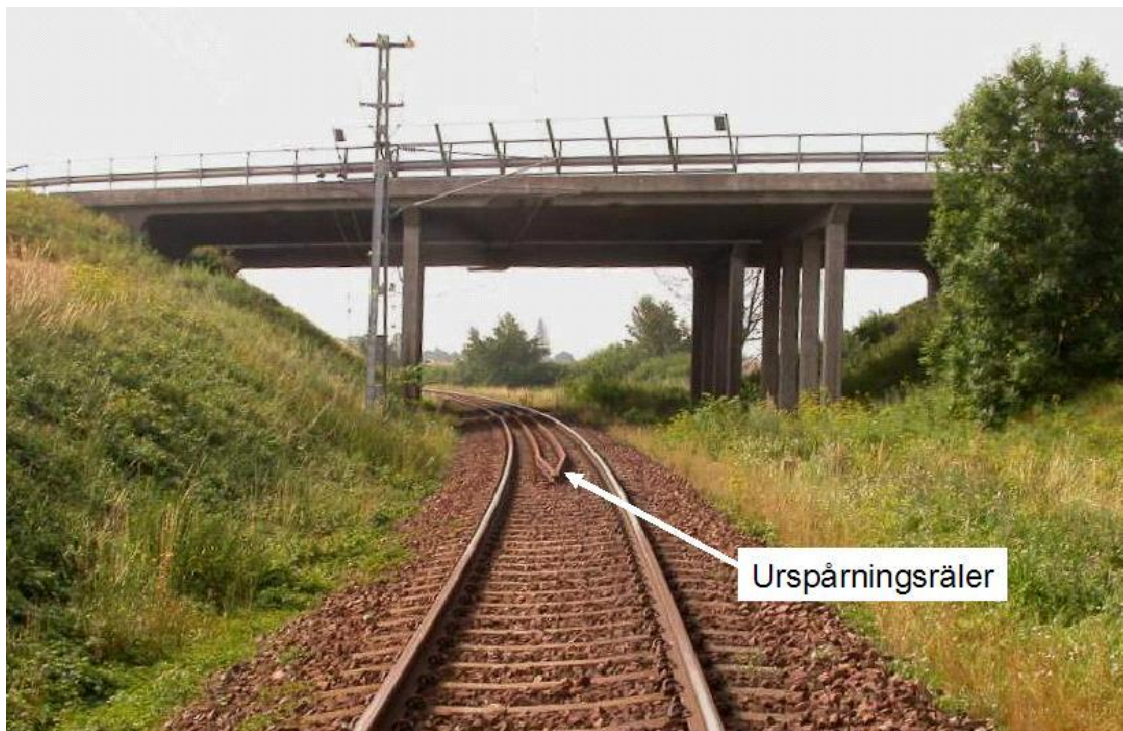
Figur 2: Bilden visar hur urspårningsräler placeras vid viadukter.
