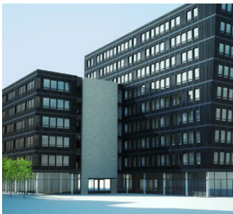
Figur 1.1: Exempel på hotellbyggnad som är uppbyggd av många moduler (BAU-HOW, 2009)
