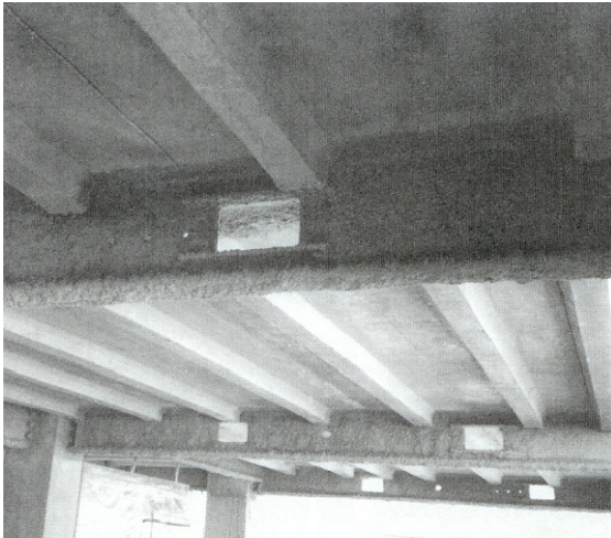
Figur 4.3: Sprutisolerade stålkonstruktion (Buchanan, 2001)
