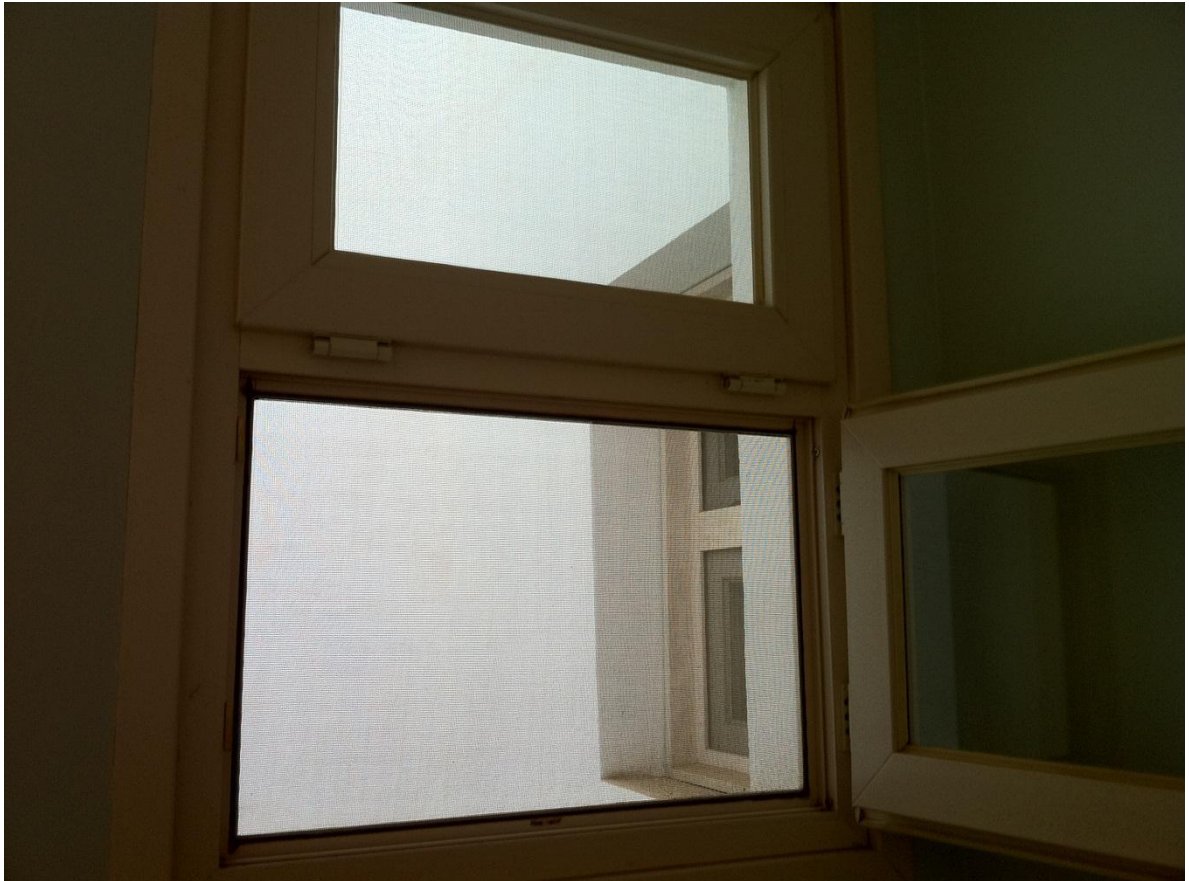
Foto 11. En bild när nedersta fönstret är öppet.
