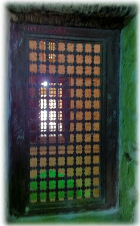
Foto 1. Visar insidan av ett träfönster direkt installerat i en betongvägg
