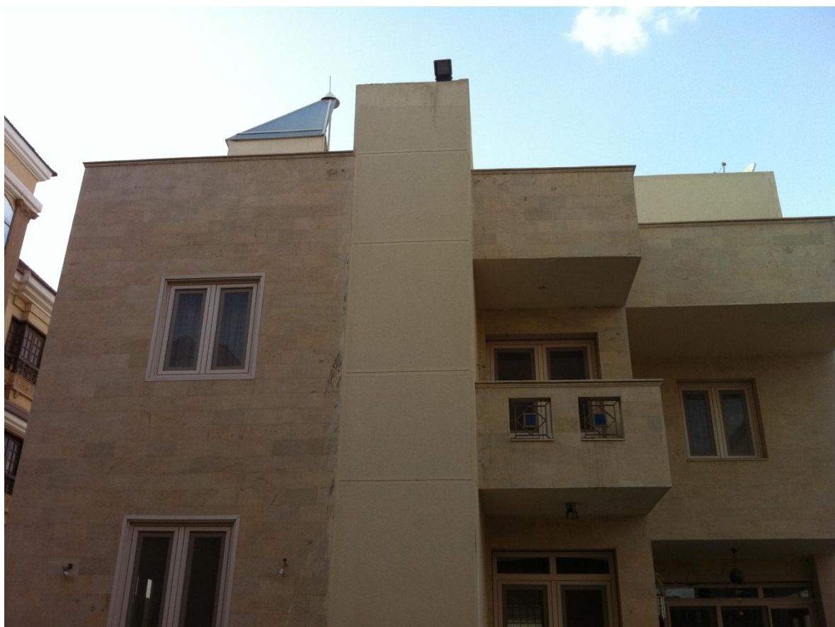
Foto 10. Den södra fasaden, ( OBS att solskorstenen inte är färdigbyggd)
