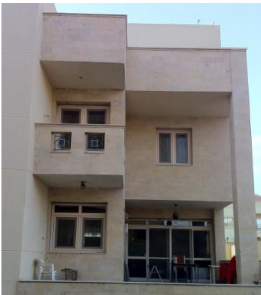
Foto 20. En fast solavskärmning på en fasad.
