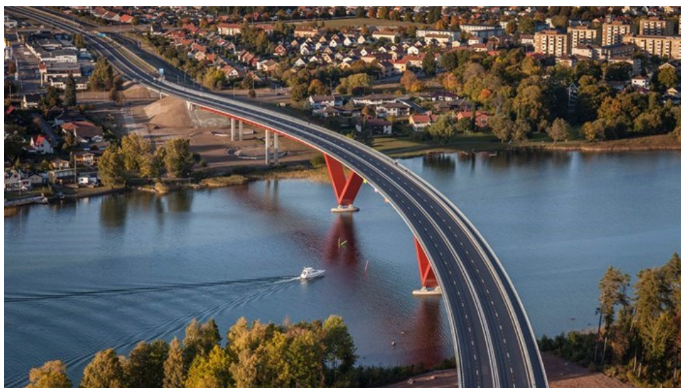
Bild 349 Färgsättning av Motalabron, Rv 50. (NCC (d), 2015)
