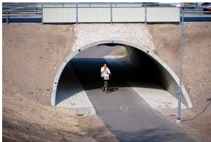
Bild 21 Rörbro i Växjö (A-betong (b). 2014).
