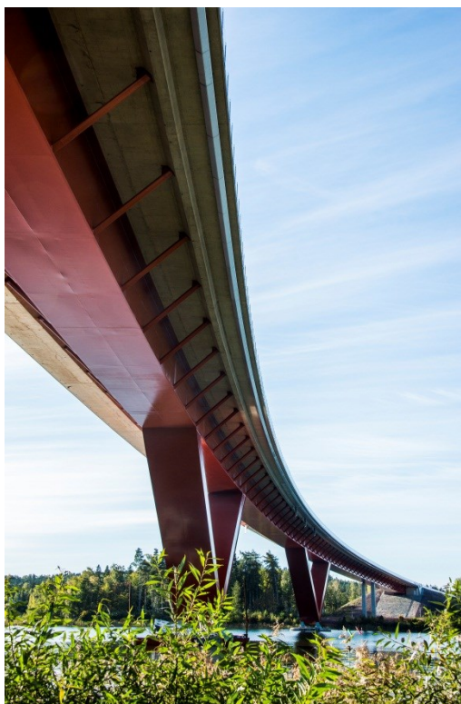
Bild 4 Motalabron, samverkansbro stål och betong, (Trafikverket (d), 2014. Fotograf: Kerstin Ericsson).
