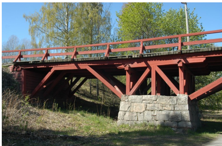
Bild 2 Träbro från 1737, Skellefteå (Träguiden, 2015).
