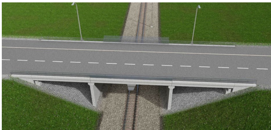
Bild 25 Steg 3, ihopjutning av farbanan (NCC (b), 2011).
