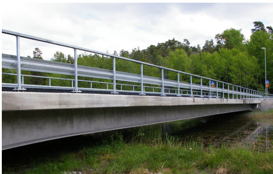
Bild 26 NCC Underhållsfri bro, byggd bro i Nynäshamn (NCC (c), 2012).
