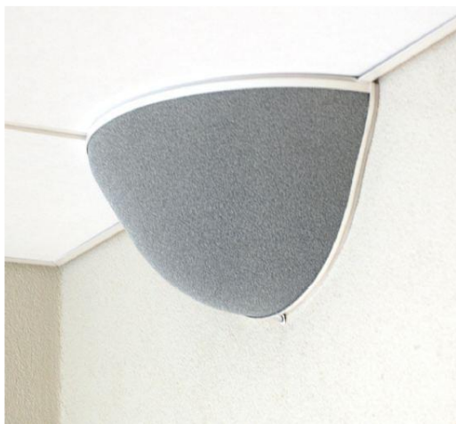
Figur 11. Deplacerande väggdon från Airson.
