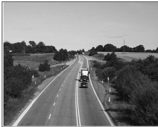
Figur 3.2 2+1-väg med spärrlinje (Wind, 2002)
