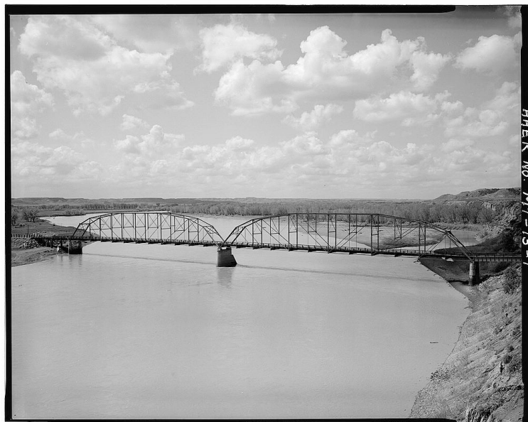
Figur 16: Fackverksbro över Yellowstonefloden av pegramtyp
