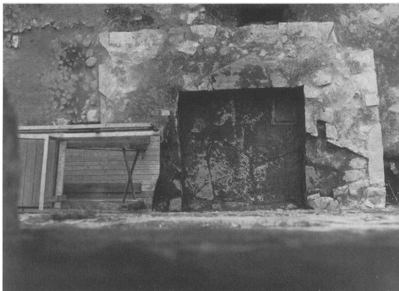
Fig. 8 Trapputbyggnaden sedd ovanifrån. Foto Svahnström, G. Ur Andersson, K. 1999. s. 129.
