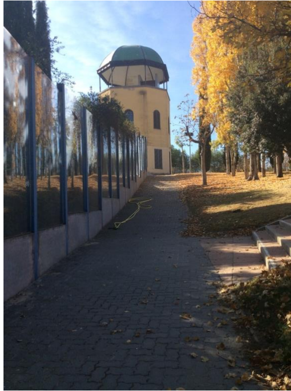
Fig. 4.9. Barreras acústicas artificiales situadas en la parte posterior del Auditorio El Torreón.
