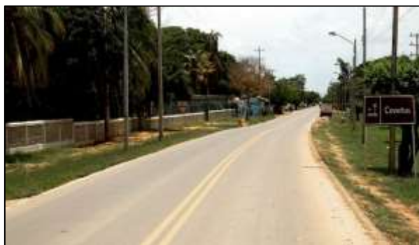
Figura 75. Vía Tolú - Coveñas.
