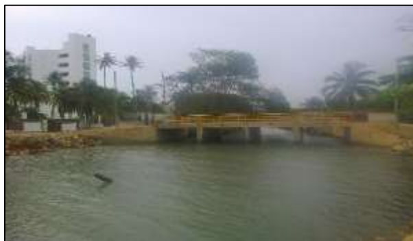
Figura 74. Canalización del arroyo Amanzaguapos. Fuente: Rosana Garnica, 2014.
