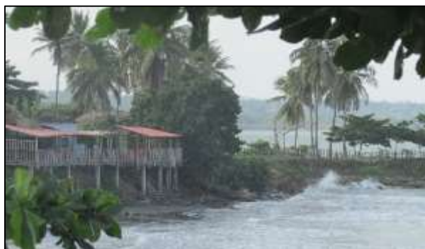
Figura 47. Infraestructuras sobre el borde litoral en área urbana de Puerto Escondido.
