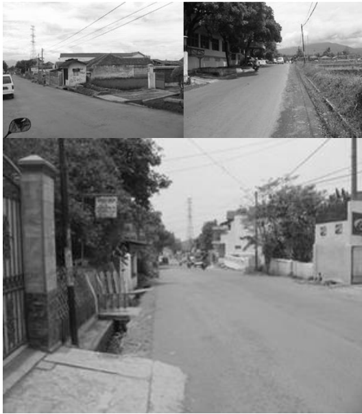
Gambar 4. Kondisi pedestrian pada jalan Jembatan (gambar atas kiri) dan ruas jalan di stasiun atau Cihaliwung sebelah Barat (gambar atas kanan dan gambar bawah)
