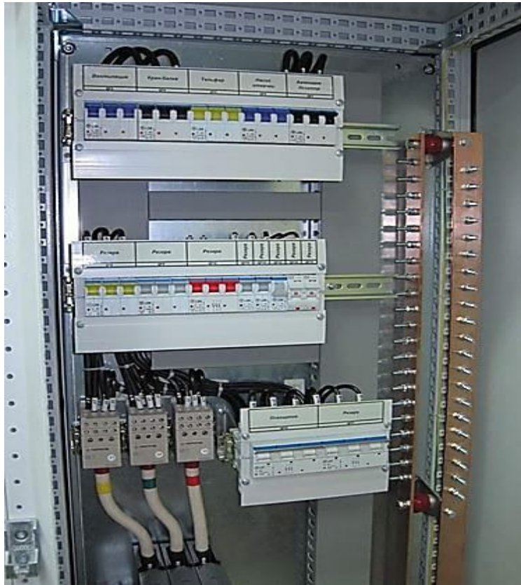
Рисунок 4.9 – Головний розподільний щит
