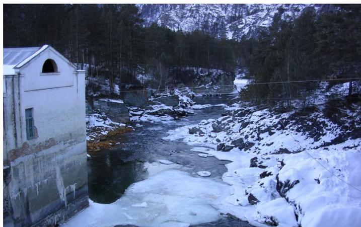
Рис. 1. Машинное отделение Чемальской ГЭС со следами паводковой волны 1969 г.
