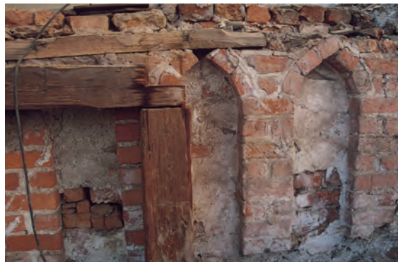
Abb. 11 Schloss Weesenstein, Kapellenflügel, Dachgeschoss, Blendnischenfeld aus spitzbogigen Blenden mit verputzten Rücklagen, 2000.
