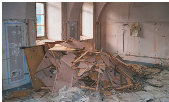
Abb. 12 Schloss Weesenstein, Kapellenflügel, ehemaliger Kapellenraum bei Beginn der Sanierungsarbeiten, 1999.
