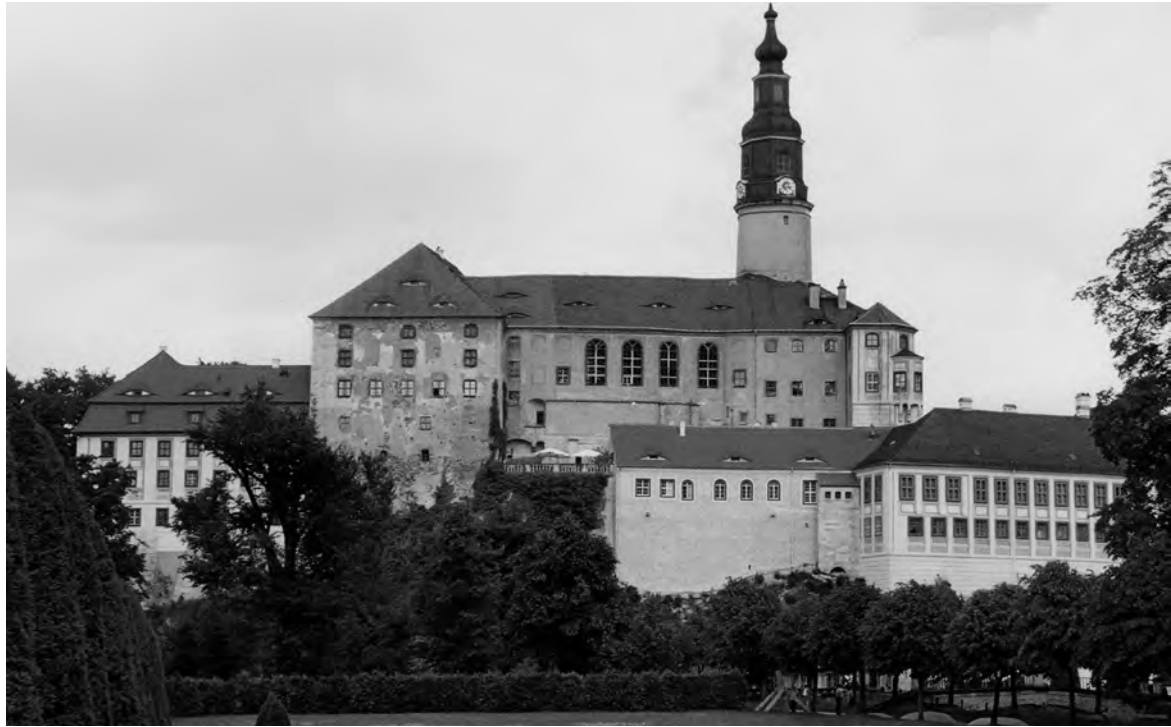
Abb. 17 Schloss Weesenstein, Ansicht von Süden, in Bildmitte unter- halb des Turmes der restaur- rierte Kapellenflügel, 2002.
