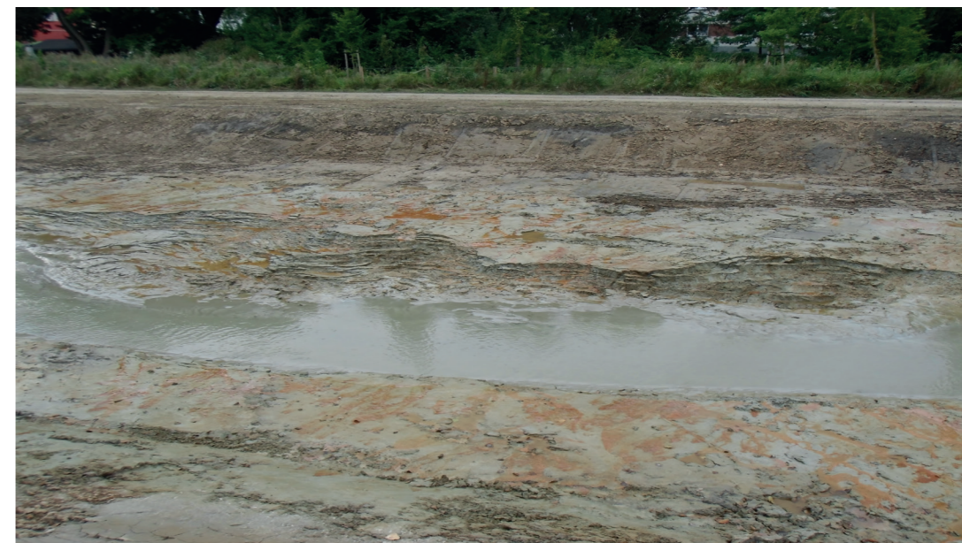
Abb. 5: Ersatzau eines ökologisch verbesserten Bachlaufs kurz nach der Fertigstellung
