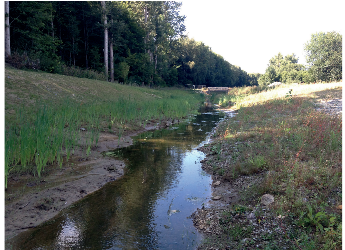
Abb. 7: Ökologisch verbesserter Bachlauf etwa 6 Monate nach dem Umbau
