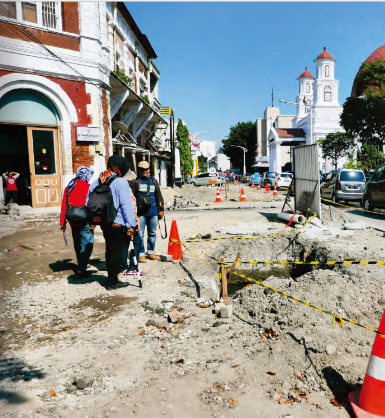
Gambar 32. Lubang galian saluran air yang sedang dikerjakan dalam penataan kawasan Kota Lama Jl. Letjen Suprpto ( Heeren Straat ) (Sumber.Dok.Balar DIY).
