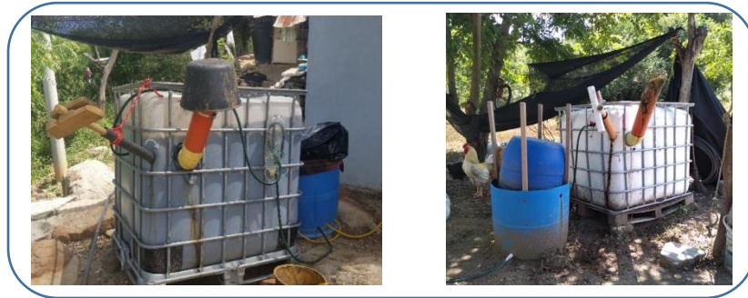
Imagen 4. Biodigestor con tanque de gas en bolsa y en caneca. Fuente: Autor. Trabajo de campo.
