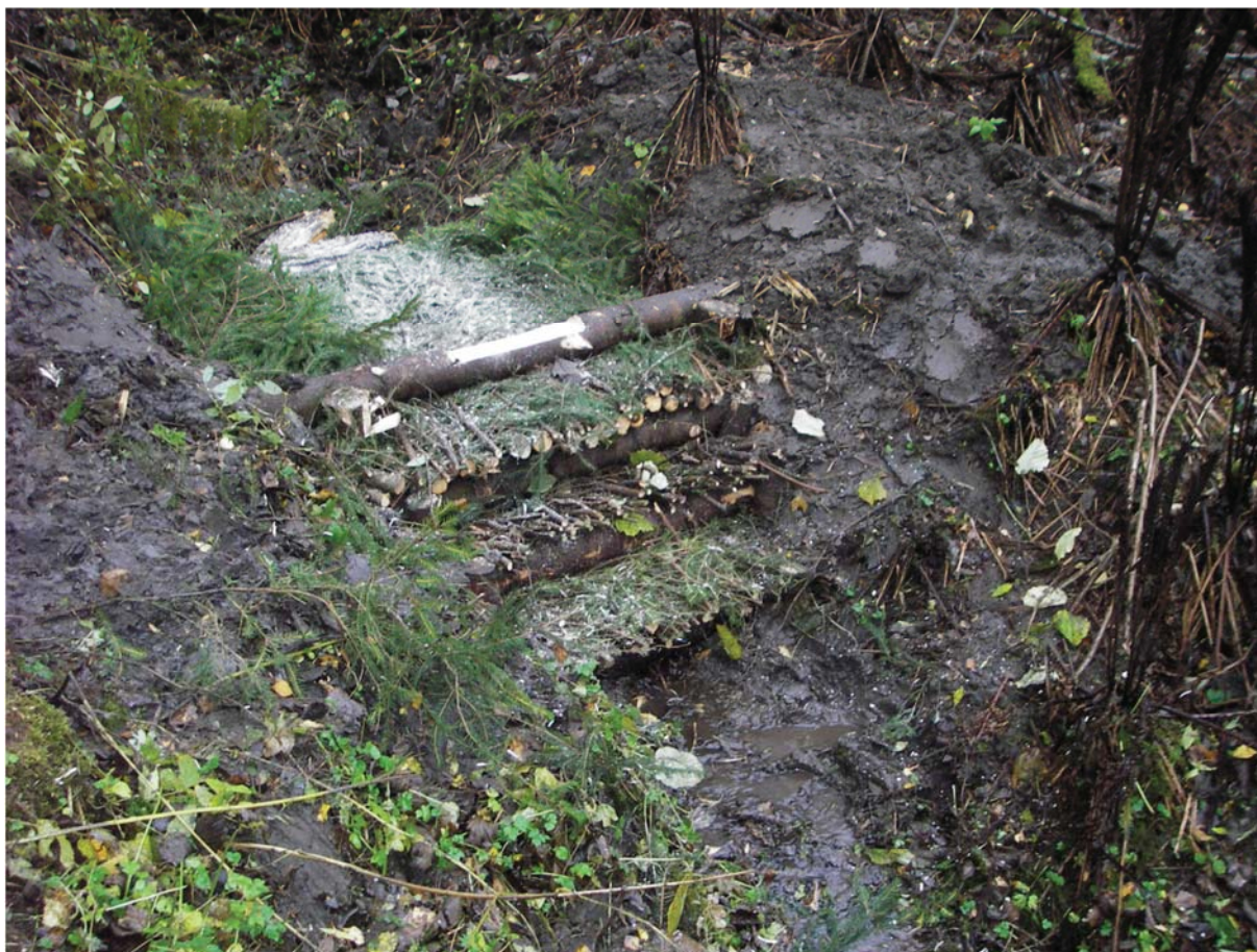
Figur 8 Eksempel på enkel kvistdam for å bremse vann i kanal ved flom
