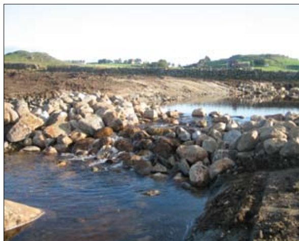
Terskler må ha steinoverdekning som tåler stor vannføring Foto: Bengt Tovslid
