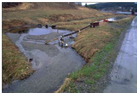
Større dammer har sjeldnere behov for tømning. Bilde viser et oppfylt sedimentasjonskammer. Foto: Bent Braskerud.
