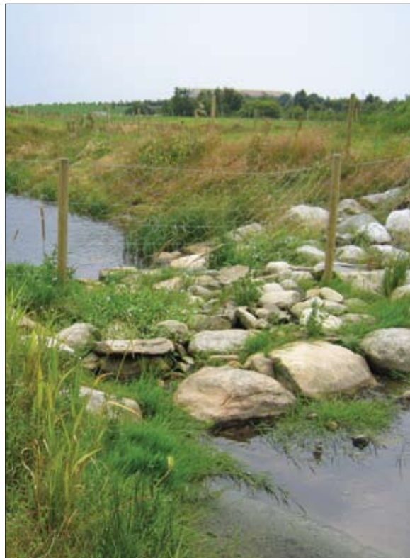
Permeable terskler kan fungere som vandringshindre for fisk, men er til glede for amfibier. Foto: Bengt Tovslid.
