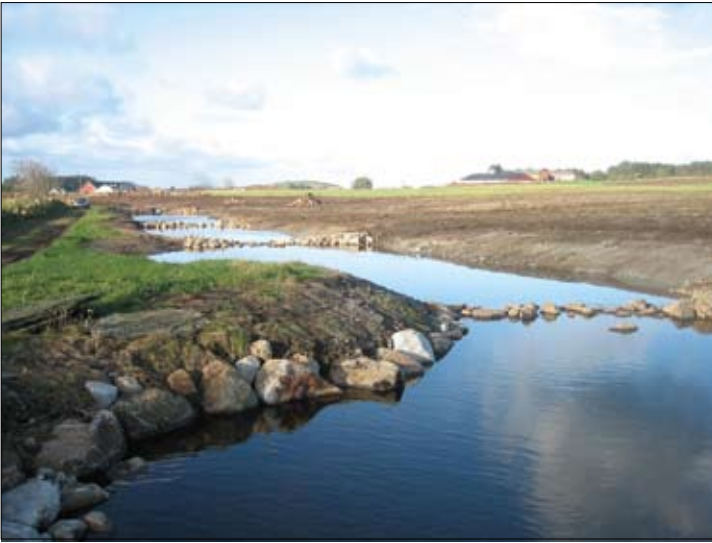
Nyanlagt fangdam med sedimentasjonskammer og vegetasjonsfiltre før planting. Foto: Bengt Tovslid.
