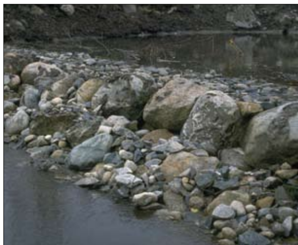
Figur 16 Permeable terskler vil kunne dempe vanngjennomstrømmingen i anlegget Foto: Rune Bakke.
