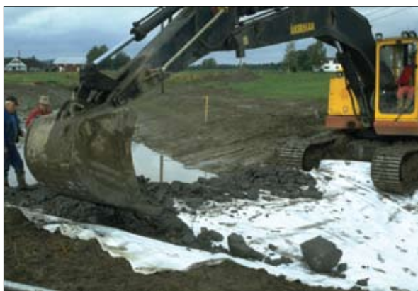
For å unngå erosjon i tersklene legges alltid fiberduk mellom jord og steinoverdekning. Foto: Bent Braskerud
