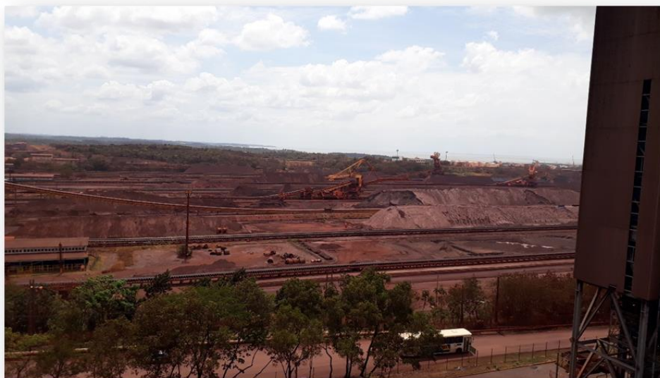
Figura 2 - Pátio de estocagem de minério de ferro – DISAL.
