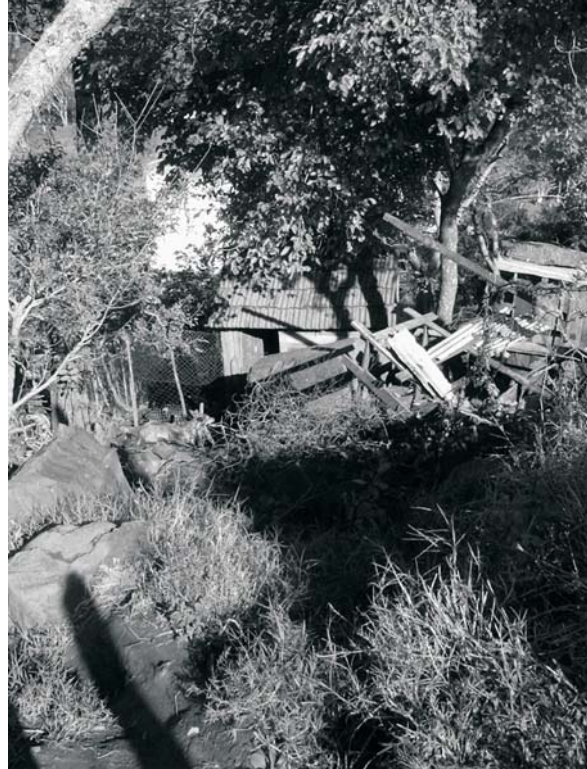
Figura 12. Moradia localizada próxima de um corte vertical com risco de rolamento de blocos e tombamento de árvores (05-07-05).
