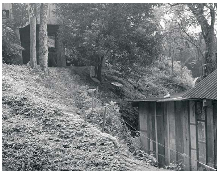
Figura 15. Moradia localizada muito próxima de um corte vertical sem proteção e com vegetação de médio/grande porte no talude (05-07-05).
