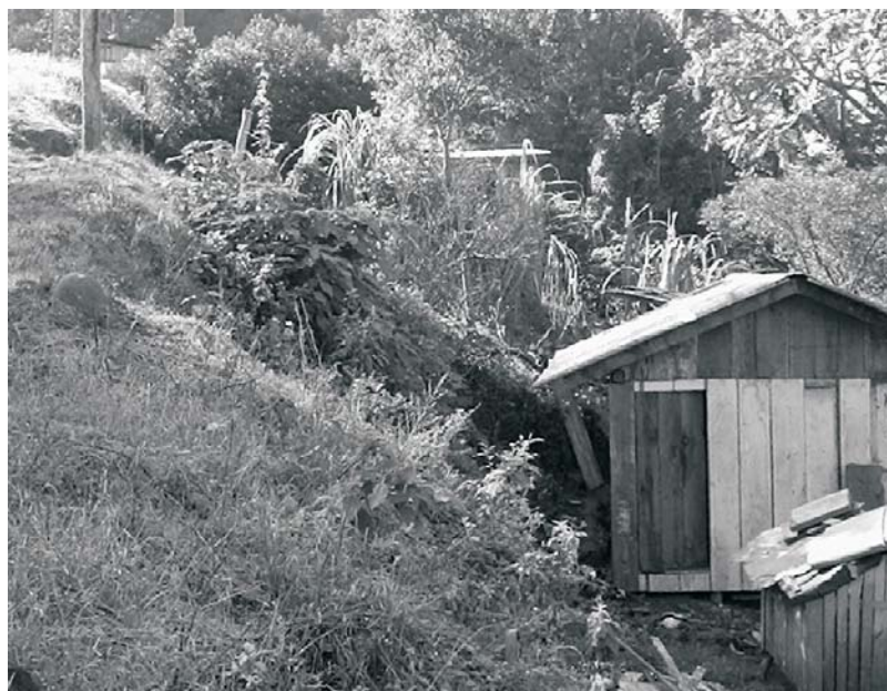
Figura 10. Moradia localizada muito próxima do corte com vegetação rasteira (05-07-05).
