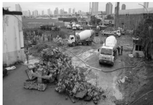
Figura 2- Pilha de armazenagem.
