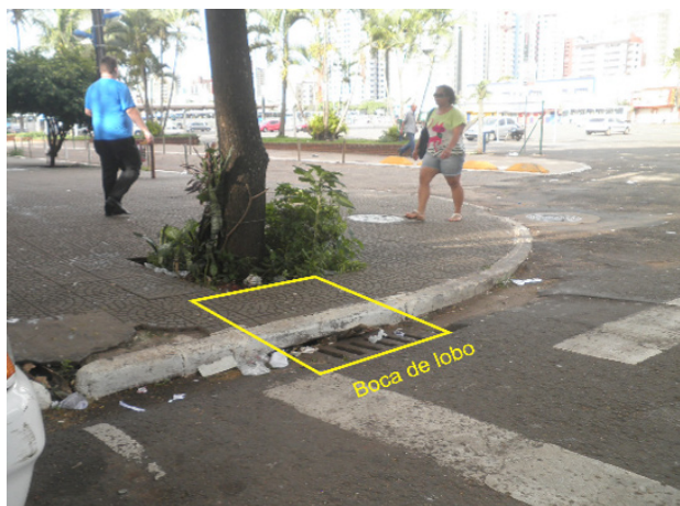
Figura 10 – Conflito da árvore com boca de lobo na Rua Joubert de Carvalho, próximo ao extinto terminal rodoviário.
