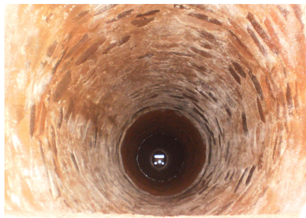
Figura 6 - Poço escavado Bairro Ipiranga, Frederico Westphalen - RS.
