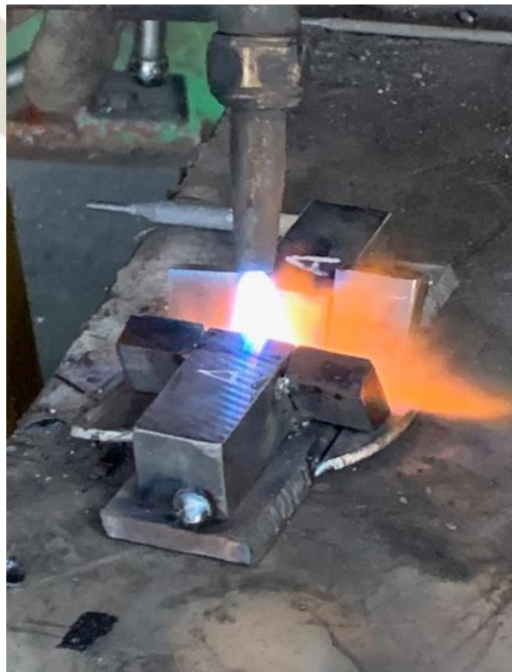
Figura 3-53 - Precalentamiento del metal base (Tracción), utilizando un equipo de Oxiacetileno [1]
