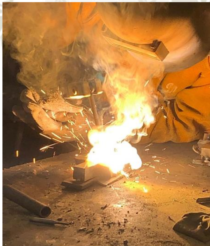
Figura 3-57 - Aplicación de la soldadura de Recargue sobre el material base (Tracción) [1]
