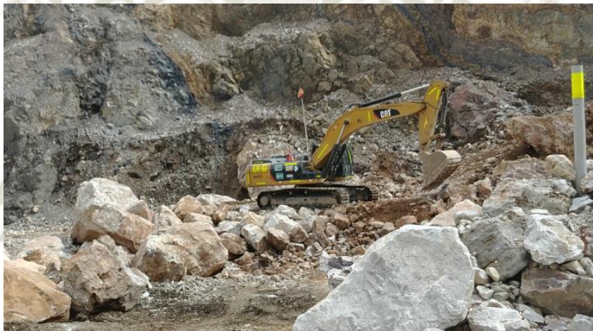
Figura 1-1 - Excavadora Hidráulica Cat 336 D2 L en operación [1]
