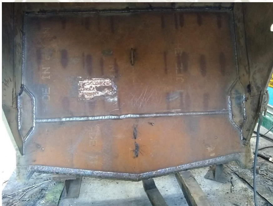
Figura 2-37 - Recargue de soldadura en hoja de cucharón de cargador frontal de bajo perfil - Scoop Cat 1300G [1]
