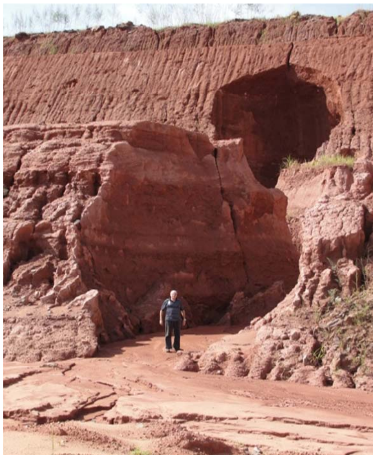
Figura 3. Efectos de la erosión en cárcavas y del sifonamiento en los sedimentos de cobertura arenisco-arcillosos, obsérvese cómo el talud es deformado por la acción del agua subterránea.
