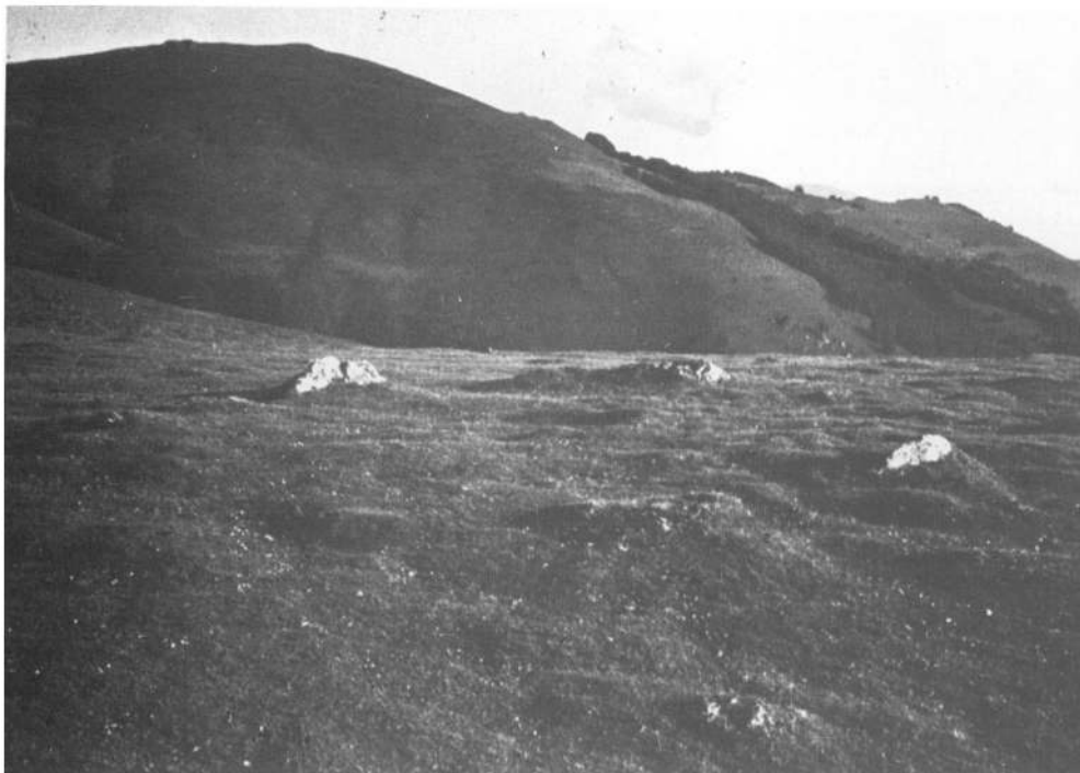
Photo 1. Vue du monument avant la fouille —Vue prise du Sud—.
