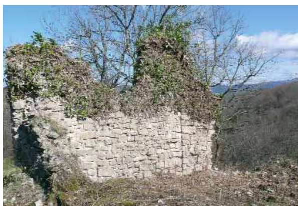
Fig 21. Aspecto que presenta el almacén (CF. 5) en la actualidad. Se puede apreciar claramente la puerta cegada.
