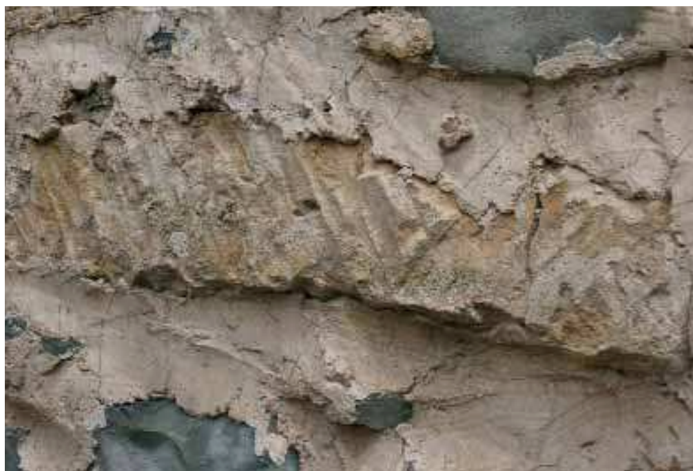
Fig 4. Detalle de la labra a azuela presente en uno de los sillares reutilizados.
