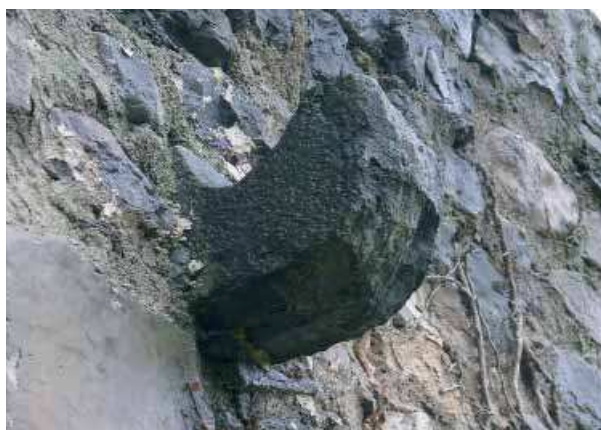
Fig 15. Detalle de una de las ménsulas.
