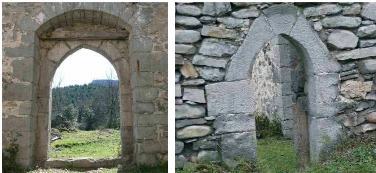
Fig 14. Imágenes del acceso principal (interior) y secundario (exterior).
