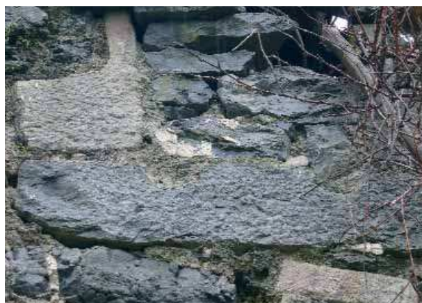
Fig 13. Detalle de la labra a picón y/o puntero presente en el dintel reutilizado de una ventana geminada.
