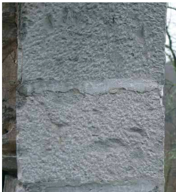
Fig 12. Detalle de la labra presente en la puerta principal del edificio.
