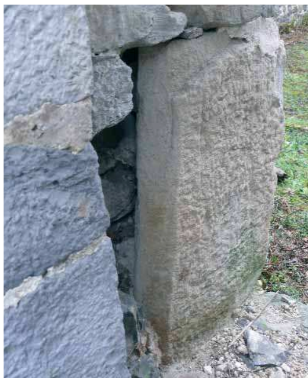
Fig 5. Jamba de la puerta en la que se dispone verticalmente la tapa de un sepulcro.
