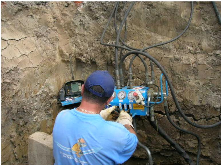
Abb. 10. Steuerung der GRUNDOPIT-Bohranlage (Stuttgart-Vaihingen, Sommer 2006).
