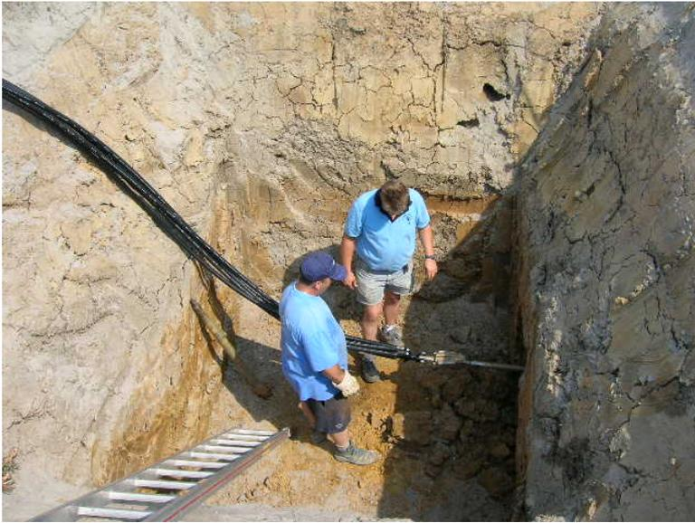
Abb. 12. Der Bohrkopf wurde gegen einen Aufweitkopf getauscht. Hinter dem Aufweitkopf werden 2 Doppel-U-Sondenleitungen ins Bohrloch eingezogen
