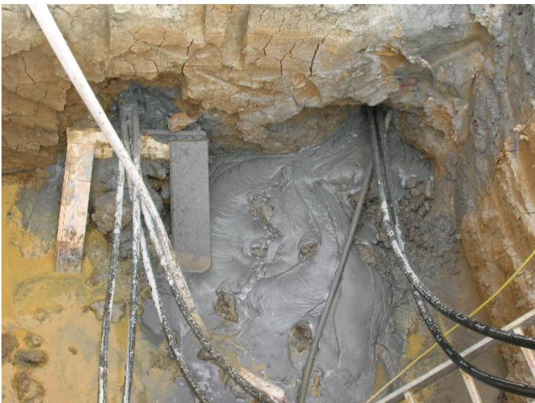
Abb. 13. In die inzwischen erstellte zweite, parallele Horizontalbohrung wurde eine U-Sonde eingezogen. Im Rückwärtsgang wird das Bohrloch mit einem graphithaltigen Thermodämmmer verfüllt.
