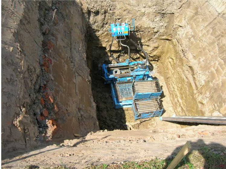
Abb. 9. GRUNDOPIT-Bohrgerät in der 3,50 m tiefen Startgrube im Testgelände Stuttgart-Vaihingen (MPA, Universität Stuttgart)
