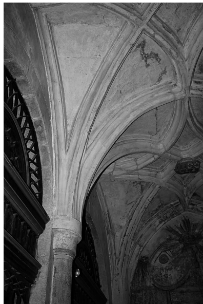
Fig. 6. Aristón sobre pilastra
