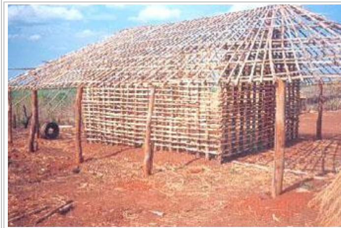
Mozambique. Envaralado de madera para vivienda. Foto: Ing. Héctor Pontigo, 1993. Por gentileza de su autor, y Elena Pontigo a R. de U.
