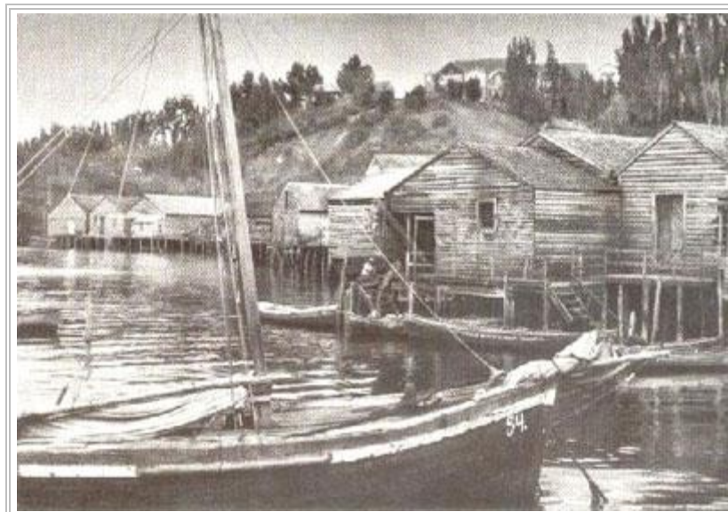
Palafitos del barrio Gamboa en la ciudad de Castro, Chiloé, Chile, 1930.
