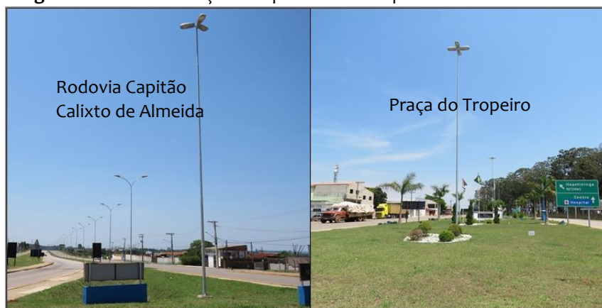
Figura 6. Rodovia e Praça onde pretende-se implantar o sistema Solar-LED.
