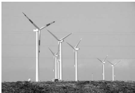
Figura 4. Equipos en el Parque Eólico Jepirachi, Guajira.
