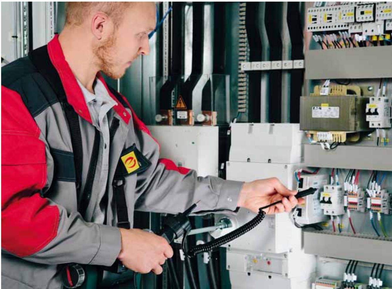
Bestandteil des E-CHECKS: Der Elektrotechniker führt Messung an dem Verteiler durch.
