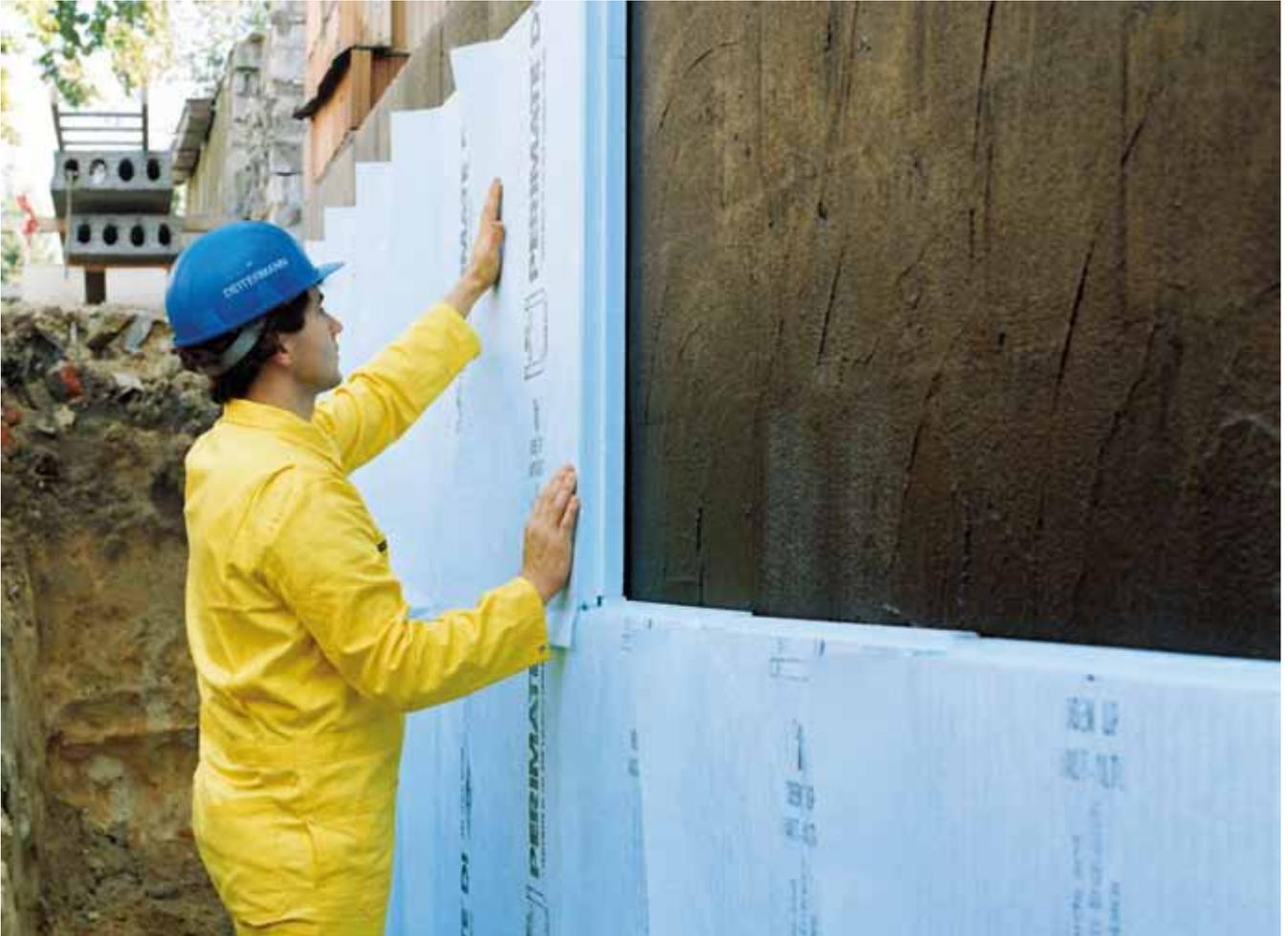
Energiesparen fängt im Keller an: Eine Perimeterdämmung verhindert, dass Wärme ans Erdreich verloren geht.
