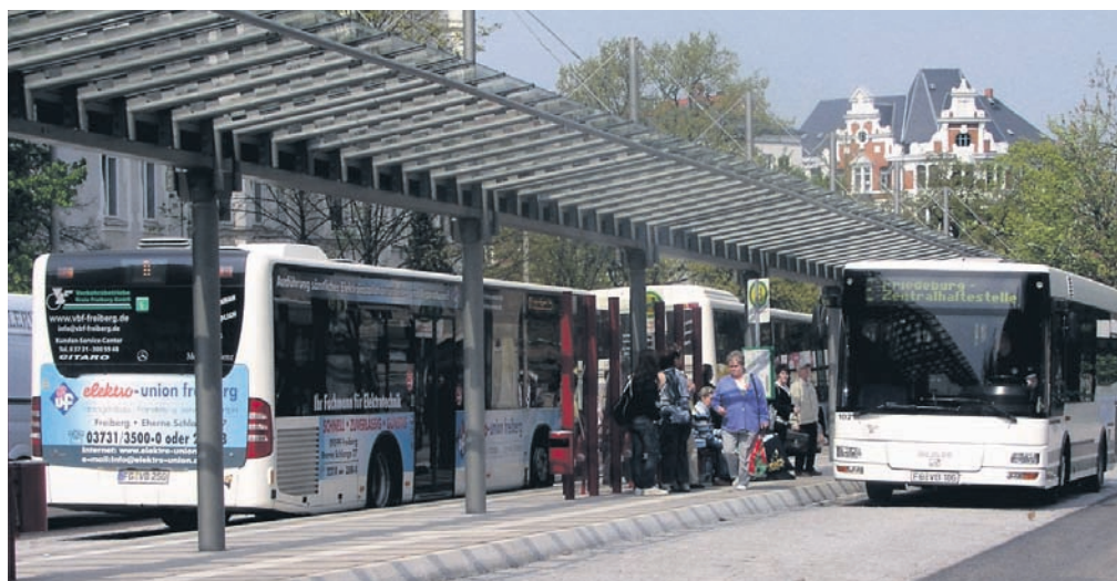
Der Haltestellenumbau ermöglicht den Gästen ein bequemes Umsteigen und kürzere Wege.
