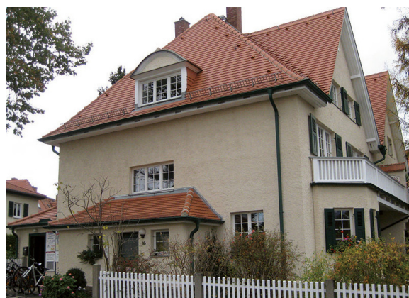
Familie Weimer lässt ihr Haus in Dresden-Hellerau mit Matrolan dauerhaft trocken legen. Die kleine patentierte Anlage im Keller war ohne nennenswerten Bau-Aufwand schnell installiert.
