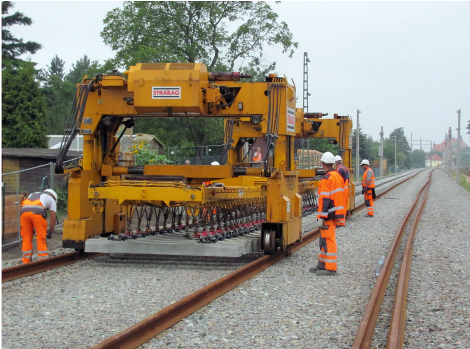
Gleisbaustelle in Radebeul – Hauptauftraggeber der Strabag Rail GmbH Bereich Ost ist die Deutsche Bahn. Aber auch für Privatbahnen wie beispielsweise die Harzer Schmalspurbahn wurden bereits Aufträge ausgeführt.
