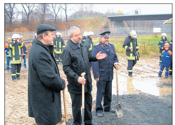
Erster Spatenstich zum Bau des Feuerwehrgerätehauses der Freiwilligen Feuerwehr Wilkau-Haßlau V.l.n.r. Landrat Dr. Christoph Scheurer, Bürgermeister, Stefan Feustel, und der Ortswehrleiter Werner Schwieder. Foto: Stephan Leonhardt
