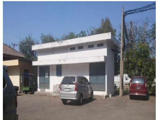
Gambar 45 Fasilitas Genset pada Apartemen Sederhana Siwalankerto
