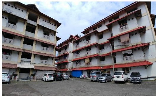
Gambar 34 Fasade Apartemen Sederhana Siwalankerto
