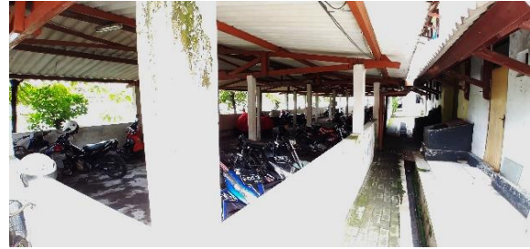
Gambar 43 Fasilitas Parkir Motor pada Apartemen Sederhana Siwalankerto
