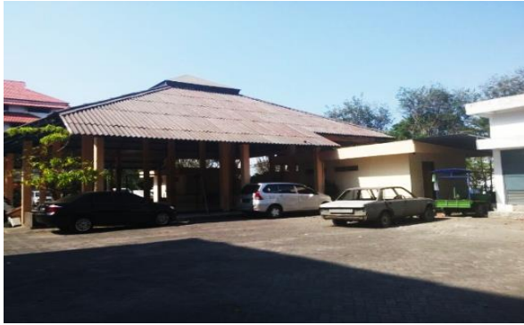
Gambar 39 Fasilitas Ruang Serba Guna pada Apartemen Sederhana Siwalankerto
