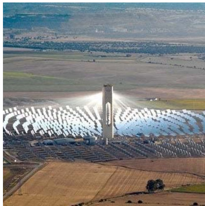
Figure-7 : Heliostats Field
