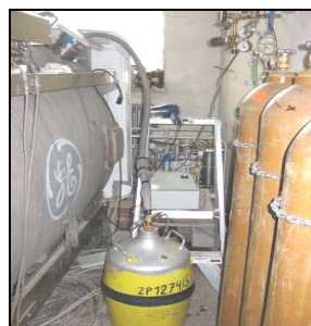
Obr. 4. Proces prechladzovania pomocou automatickej riadiacej jednotky kvapalného dusíka. Fig. 4. Overcool process with and automatic controlling unit of liquid nitrogen.
