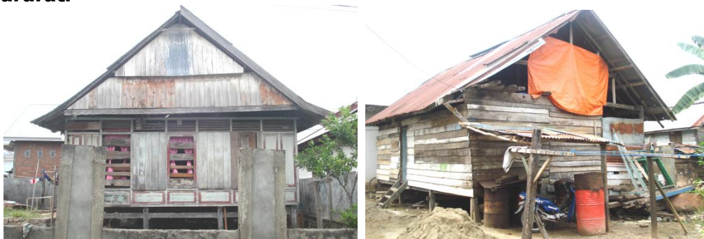
Gambar 3. Kondisi rumah warga yang sangat sederhana dan berkesan darurat
