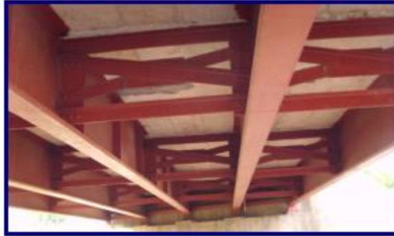
Figura 2.1: Marcos transversales de acero Tipo “X”.
