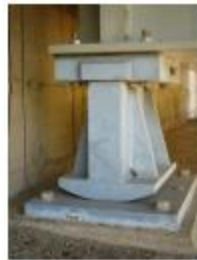
Figura 2.4: Apoyo de expansión metálico fijo de un puente.
