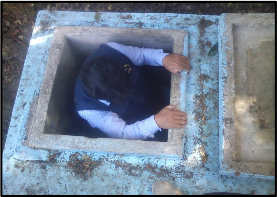
Foto N°12 inspección de cámara húmeda
