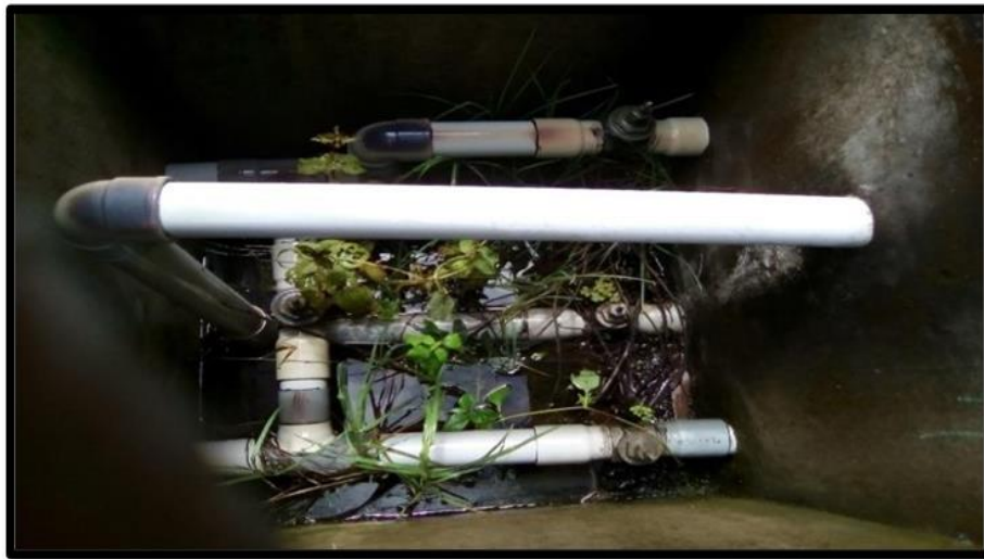
Figura 13.- Válvulas del reservoirio
