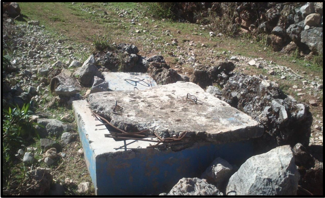
Foto N°11 cámara rompe presión tipo7
