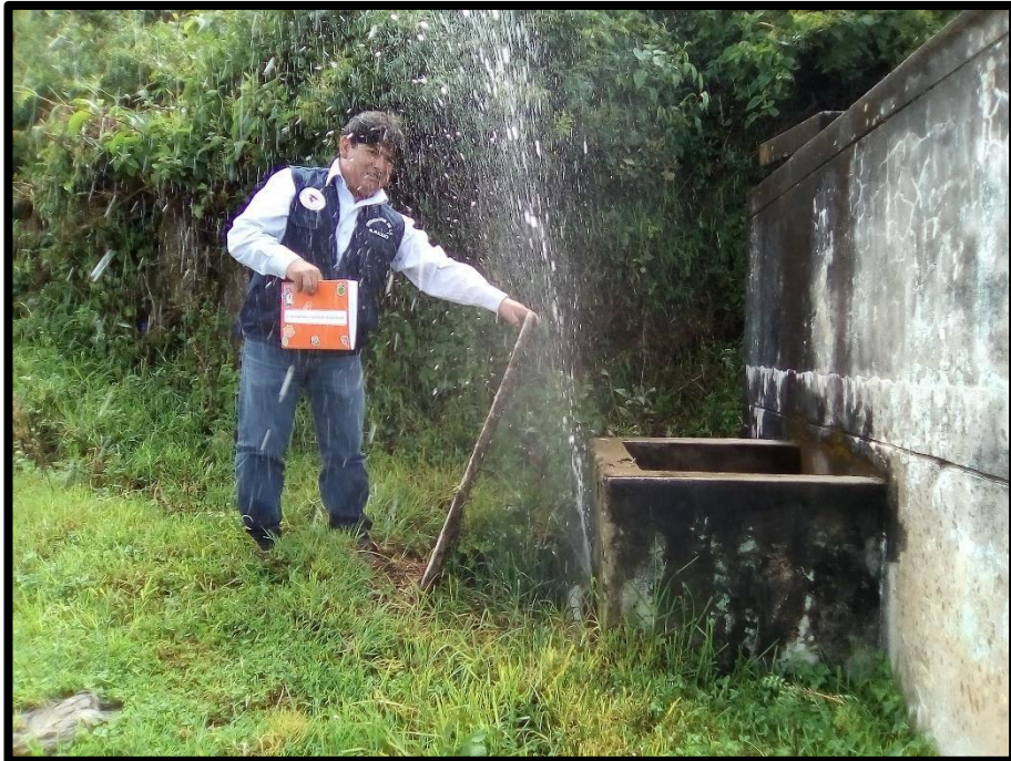
Foto N°6 Tuberías rotas
