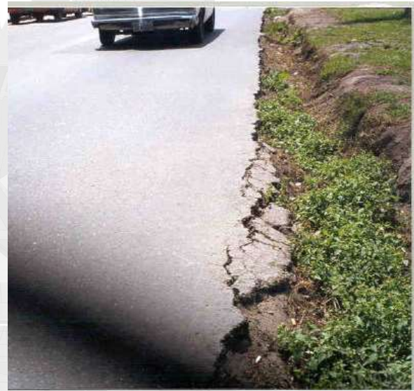
Figura 4.17: Desintegración bordes. Fotografía 4.13: Desintegración bordes.
