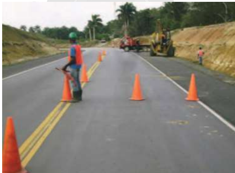
Fotografía 6.4: Nivelación de bermas con material granular.
