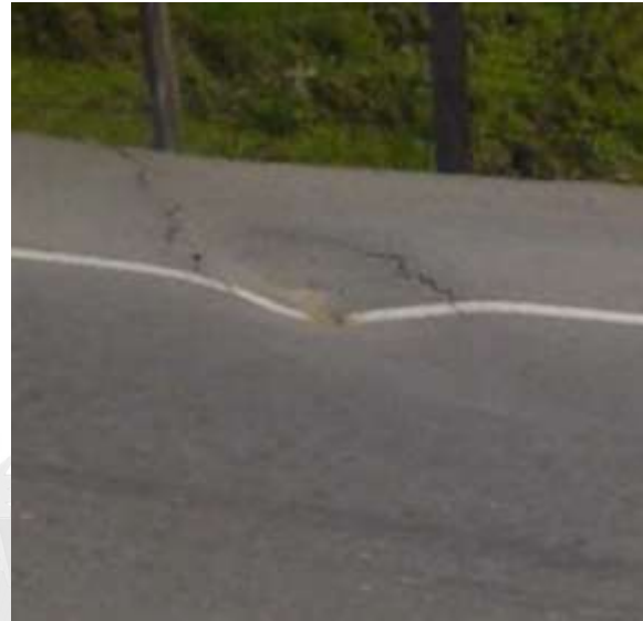
Fotografía 4.11: Hundimiento.
