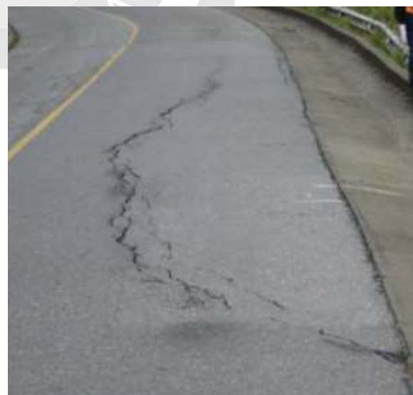
Fotografía 4.3: Fisura en arco.
