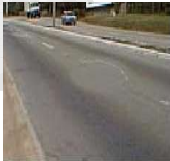
Figura 4.14: Esquema de hinchamiento. Fotografía 4.10: Hinchamiento.
