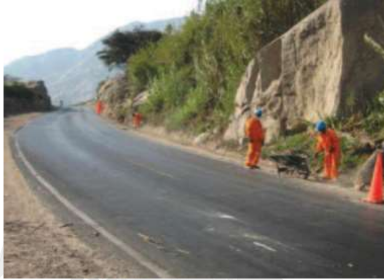
Fotografía 6.3: Bacheo de bermas con material granular.
