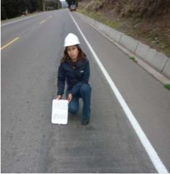
Fotografía 5.13: Fisura longitudinal 230 + 700 km.
