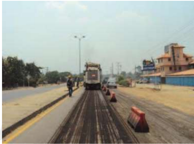
Fotografía 6.8: Microfresado de Carpeta Asfáltica.
