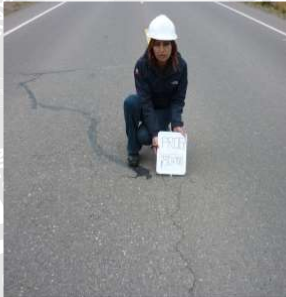
Fotografía 5.13: Fisura longitudinal 230 + 700 km.
