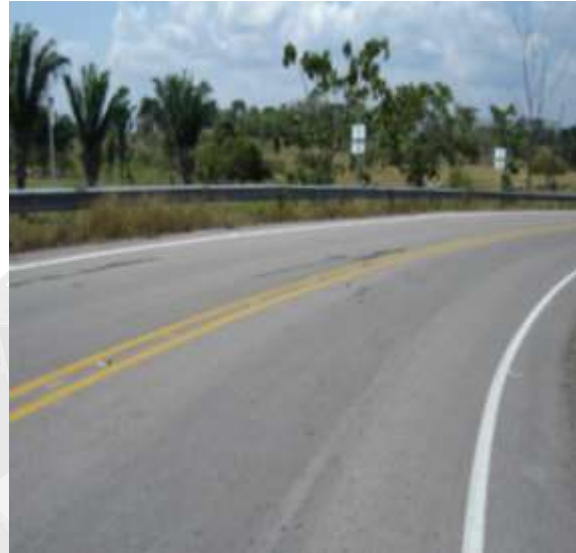
Fotografía 4.15: Desgaste superficial.
