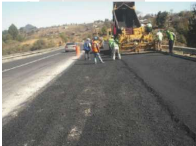
Fotografía 6.7: Fresado de Carpeta Asfáltica.
