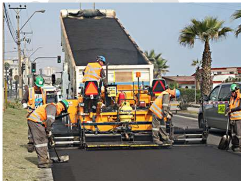
Fotografía 6.6: Recapados Asfálticos.
