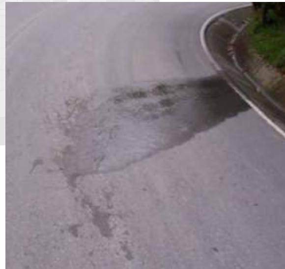
Fotografía 4.20: Afloramiento de agua.
