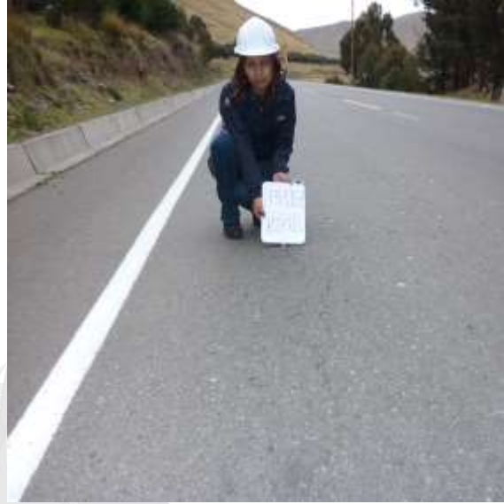
Fotografía 5.13: Fisura longitudinal 230 + 700 km.
