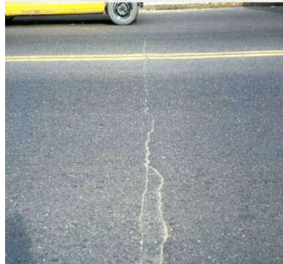
Fotografía 4.5: Fisura transversal.
