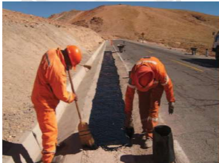
Fotografía 6.9: Nivelación de bermas con mezcla asfáltica.
