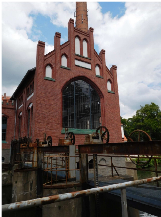
Obr.č.2: Cottbus, Německo. Bývalá vodní elektrárna, nyní využívaná jako administrativní budova. Zdroj: Archív autora
