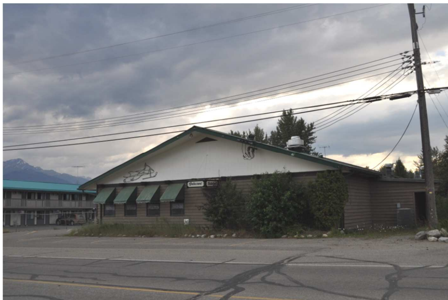
Obr. č.3: Příklad kanadského brownfieldu: opuštěný objekt bývalého stravovacího zařízení ve městě Valemount, Britská Kolumbie (1020 obyvatel). Zdroj: Archív autora
