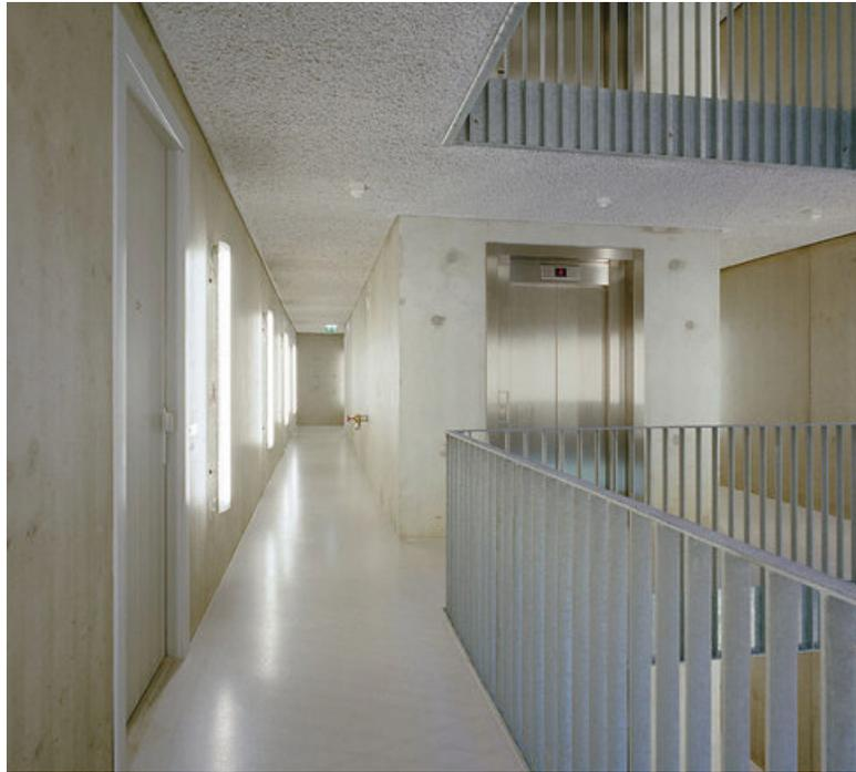
Abb.: Blick auf Fahrstuhl und einhaustes Treppenhaus, Geländer verzinkt, Decke mit Akustikspritzputz versehen, Wände aus Beton unverputzt
