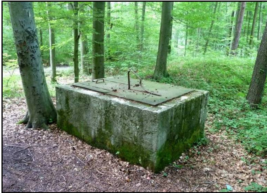
Abb. 62: Schachtplombe des ersten Lichtloches des Zwieseler Tiefen Erbstollns.
