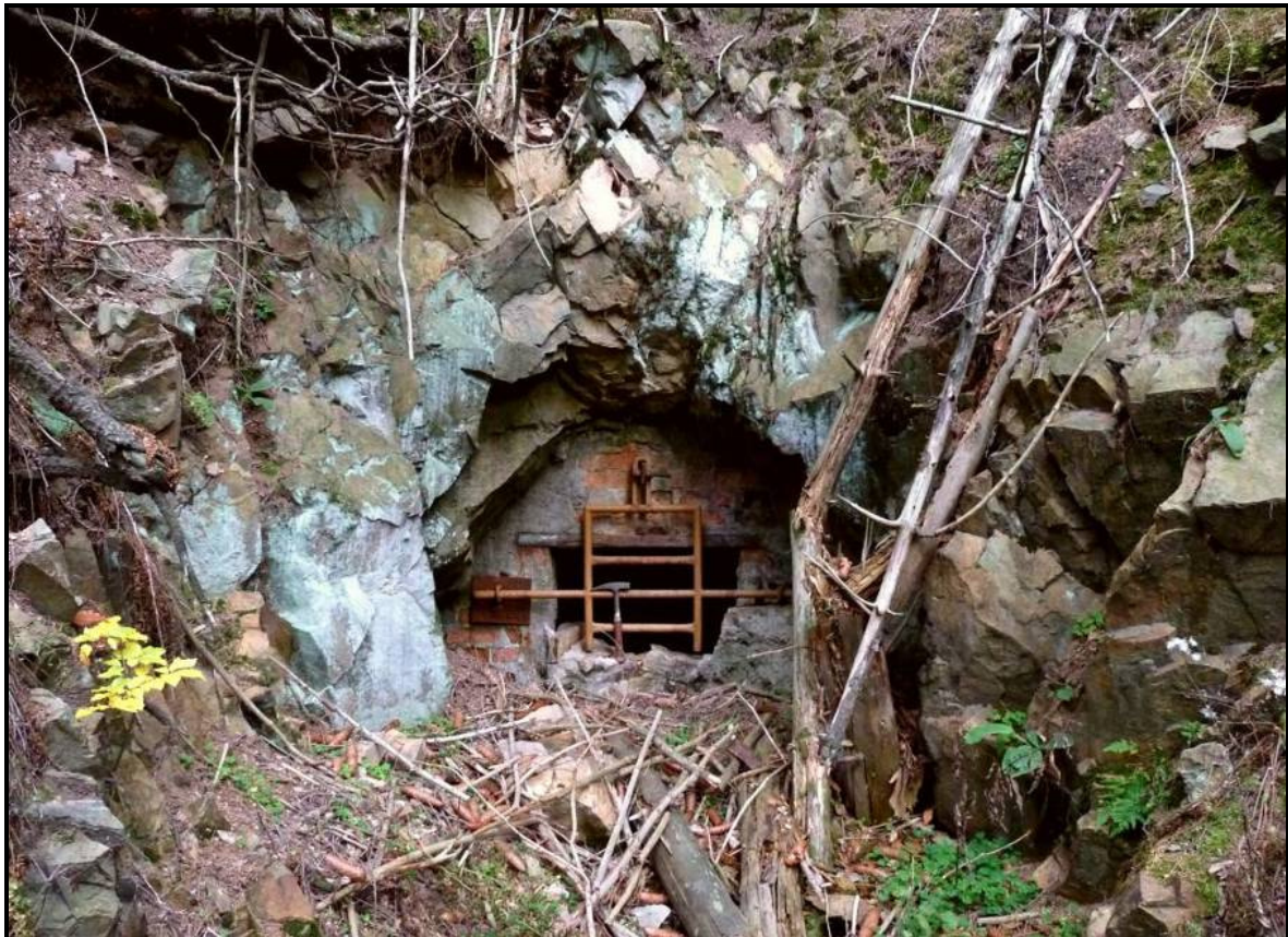
Abb. 15: Mundloch des Hilfe Gottes Erbstollns in Quarzporphyr (Pc).
