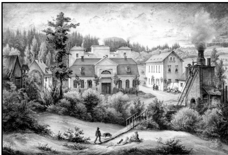
Abb. 31: Blick auf das Gräflich Einsiedelsche Eisenhüttenwerk Berggießhübel. (Quelle: Gemälde von Traugott Faber um 1840, aus SALEWSKI 1965)
