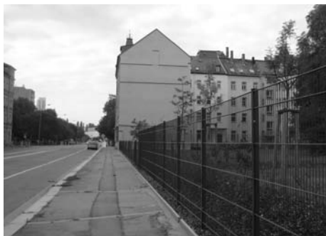
Abbildung 43: Straßenraumsituation nach dem Abriss von Altbaustruktur an der Mühlenstraße als Schritt zur Umsetzung des Uferparks.
