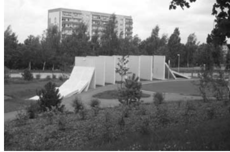
Abbildung 46: Privates Engagement einer Wohnungsgenossenschaft zur Wohnumfeldgestaltung.
