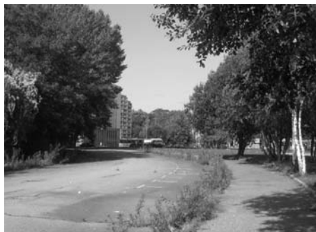
Abbildung 44: Stillgelegte Falkestraße kurz vor der Offenlegung der Chemnitz als Baustein des Uferparks.
