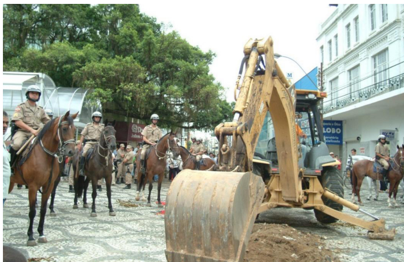
Figura 1 – Escavadeira destrói calçadão, protegida por policiais – 1.º/3/2004
